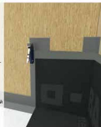
**6** Все торцевые соединения следует выполнять с помощью ленты MasterSeal 934 200 мм, при укладке мембран в середине ленты должен образоваться ровный шов не более 5 мм для обеспечения полной герметичности.
